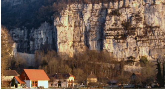
Fig. 87 - Rampe d'accès le long de la falaise depuis la plaine du Guiers, au défilé des Echelles, pour entrer dans la vallée de Couz. On aperçoit le mur de soutènement entre les arbres et l'entrée dans le défilé. Cette portion de route, par les Sardes au XVIII e siècle pour être utilisée jusqu'en 1820.
