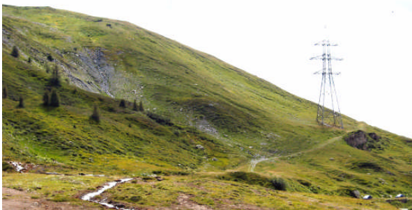
Fig. 137 et 138 - La route passe au pied d'éboulements plus ou moins récents, marqués par de nombreuses niches d'arrachement en creux.
