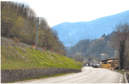
Fig. 95 – La gorge de l'Hyères sous Vimines, avec la voie ferrée et la route. Le torrent passe en contre-bas de la route.
