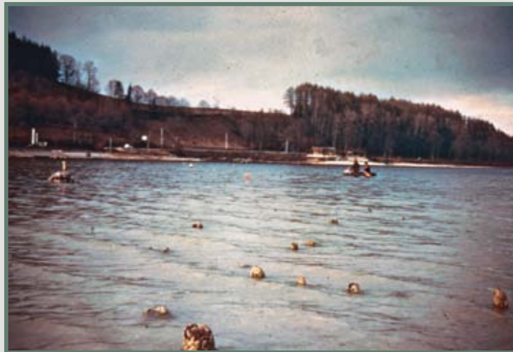
À Noël 1971, seuls les pieux les plus hauts dépassent la surface du lac.
