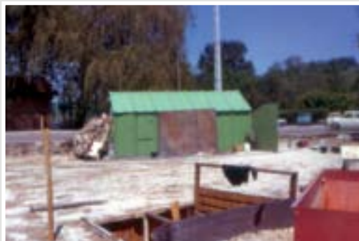
Installation de la base de travail à Pâques 1972.
